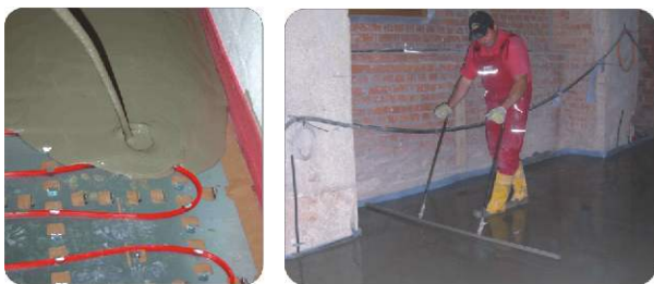
Vergießen der Einfachplatten mit dem System-Fließmörtel
