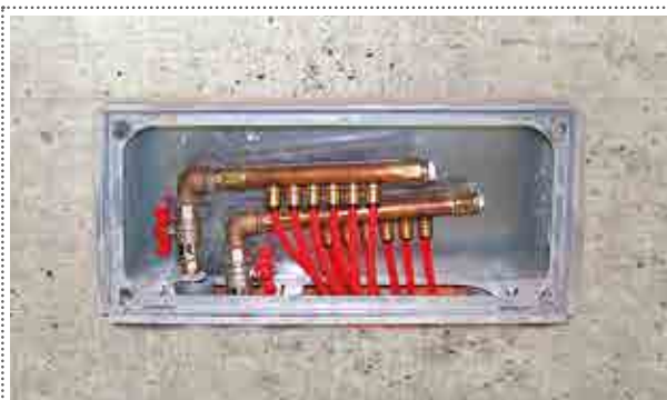
Блок распределителей шестиканальный.
