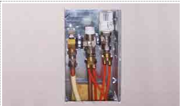
Регулирующий блок, вариант 2 с двухканальным вторичным распределителем.
