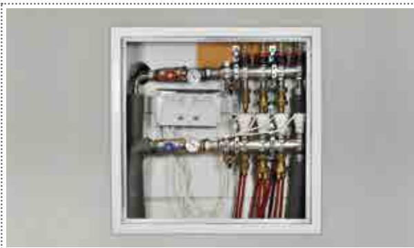
Распределение на этаже с использованием обычного многоканального распределителя (рис. слева) и effidur HKV-VA (рис. справа), оснащенного вторичными распределителями.
