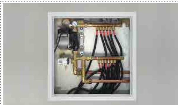
Блок распределителей шестиканальный на регулирующем узле.
